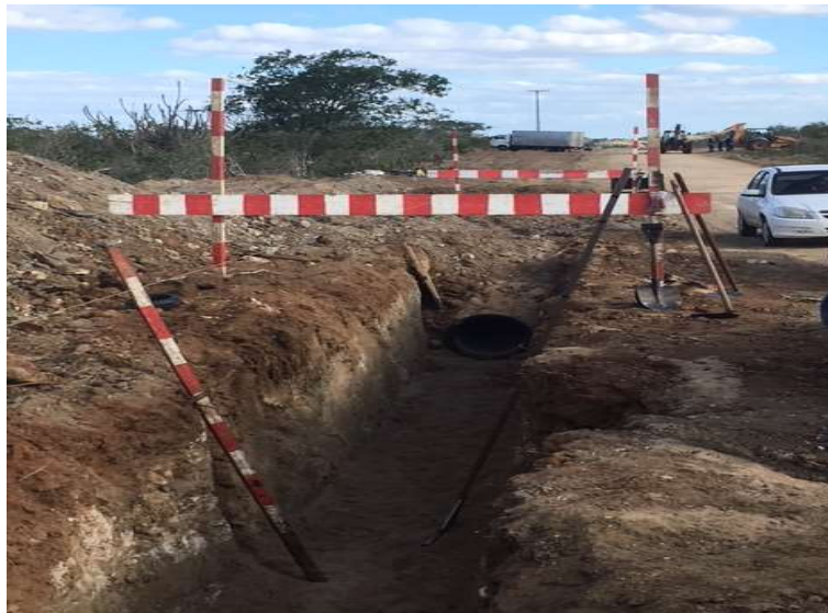
Figura 34. Detalhe de construção da adutora.
