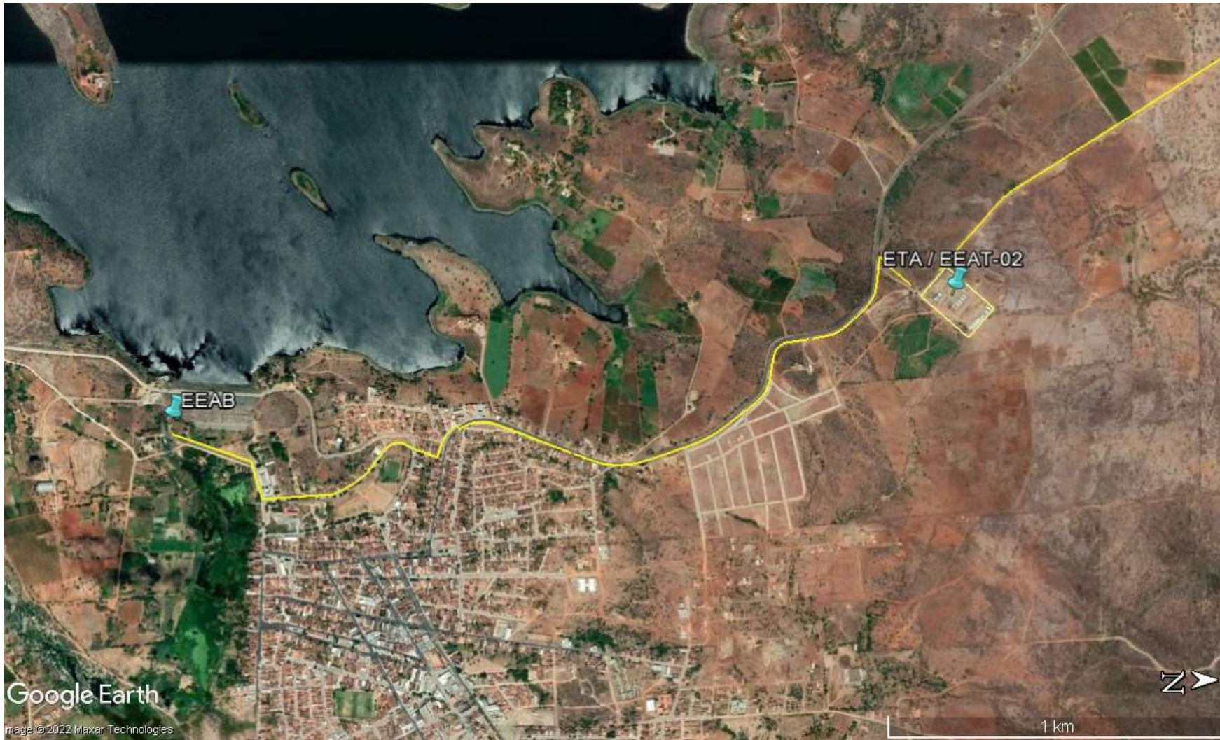
Figura 5. Trecho Captação em Boqueirão - ETA. E EEAT 02
