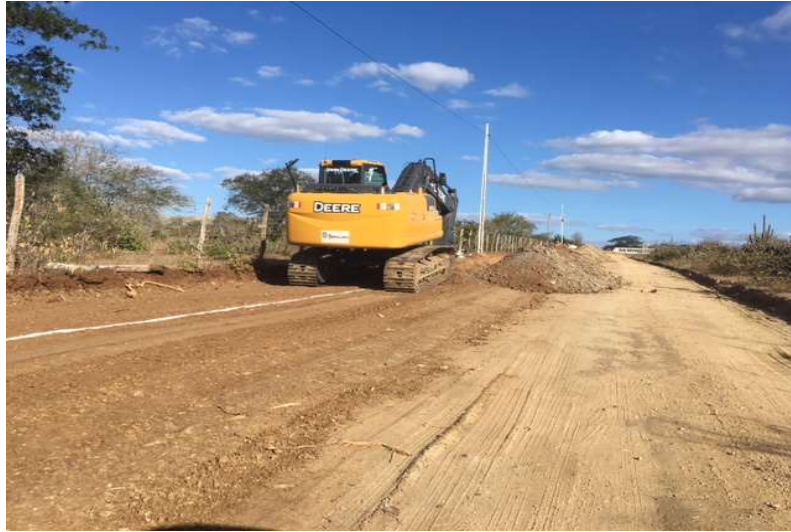
Figura 33. Abertura de valas na faixa lindeira das estradas
