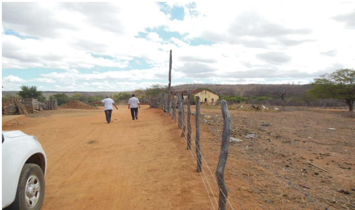
Figura – 18. Exemplo de ocupações esparsas na área aonde foi implantado a adutora.
