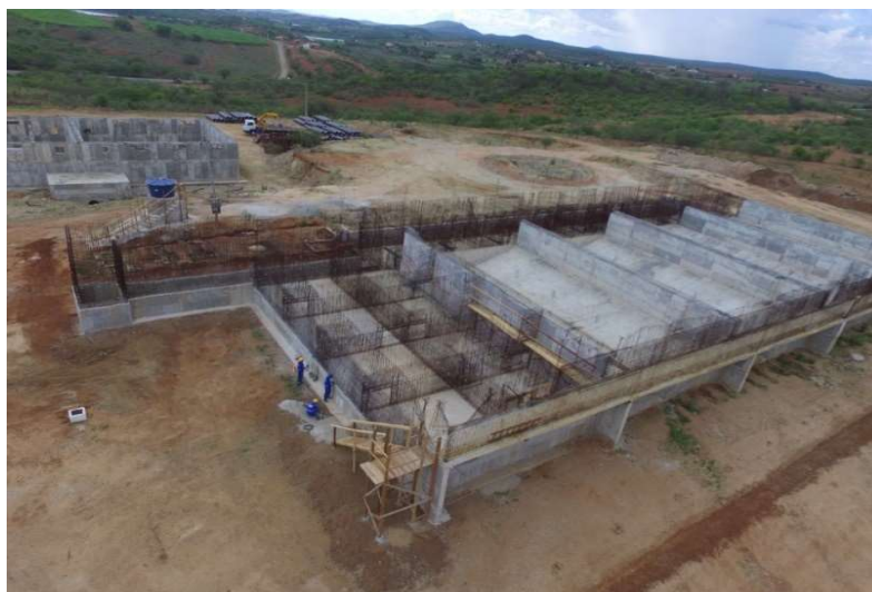
Figura 31. Foto da Construção da ETA Boqueirão (atualizada em fevereiro de 2022).
