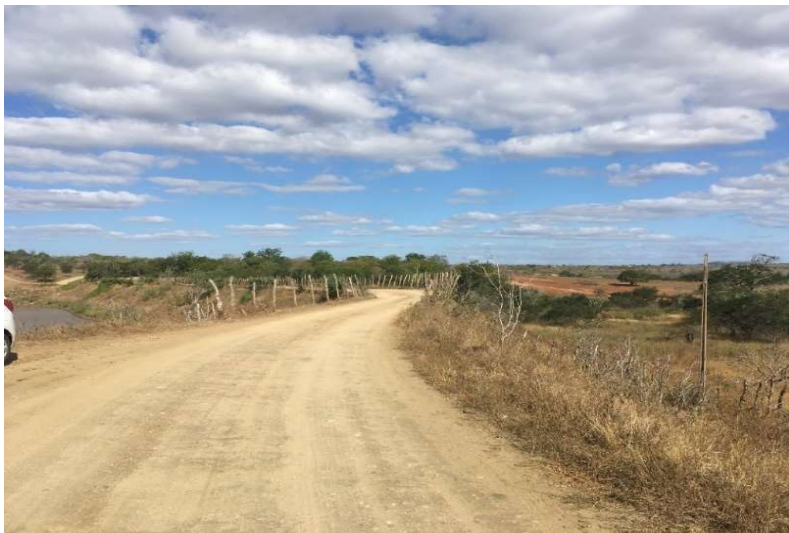
Figura 32. Traçado da Adutora Próximo a um Açude (APP)
