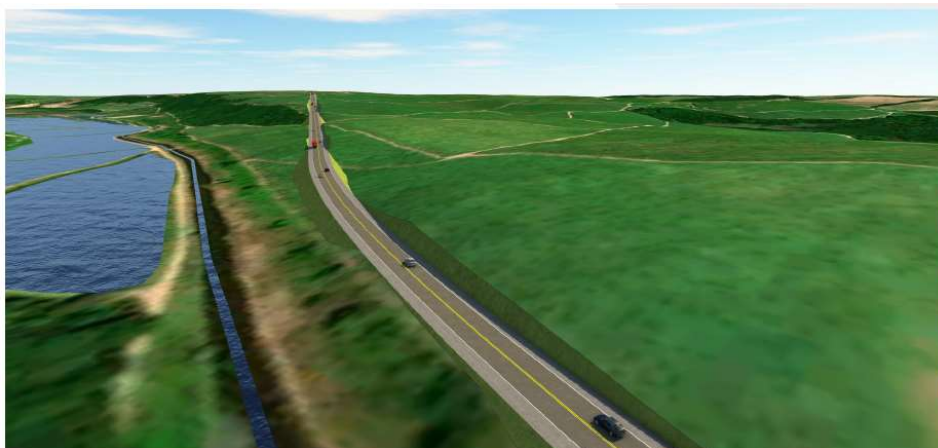
Figura 4: Complemento Rodoviário da PB-011 de Forte Velho. Entre PB-019 (Lucena) com 5,0 Km de extensão aproximada.
