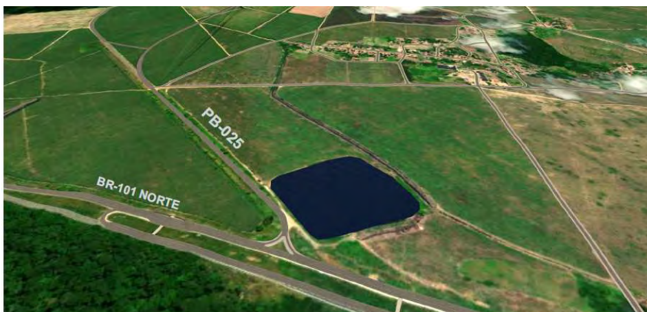
Figura 5: Restauração da PB-025 até o entroncamento com a Rodovia BR-101/PE, com extensão aproximada de 750,0 metros.
