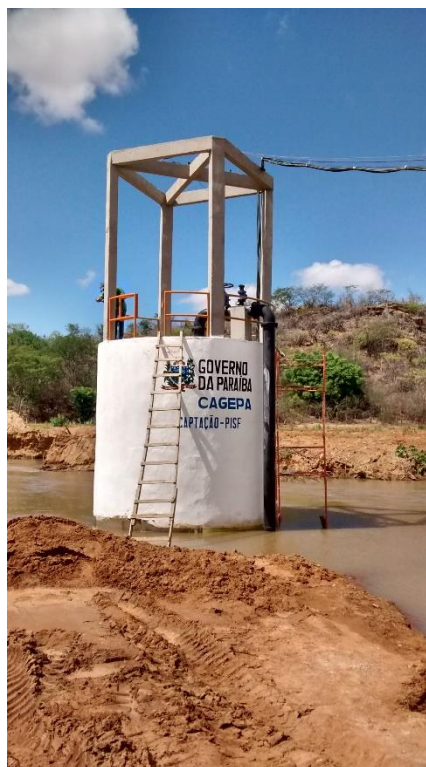
Foto 1: Poço amazonas com drenos radiais, leito do rio Paraíba
