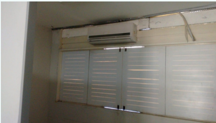
Figura 3: Adaptações - Instalações de Ar Condicionado
